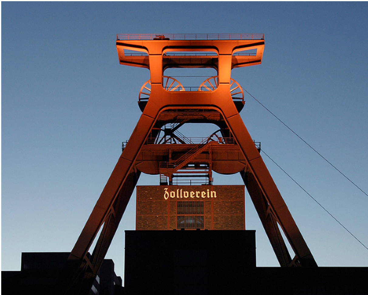
Schacht 12 der ehemaligen Zeche Zollverein in Essen. Quelle: wikipedia, Urheber Thomas Robbin
